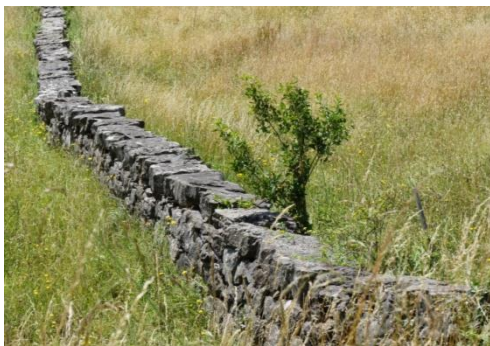
Abbildung 15: Freistehende Trockensteinmauer
